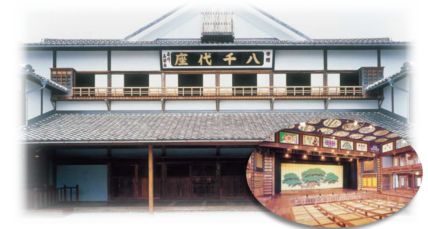
八千代座（山鹿市：写真提供 熊本県）
